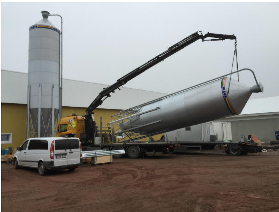
Resning av silo direkt från lastbilsflak.
