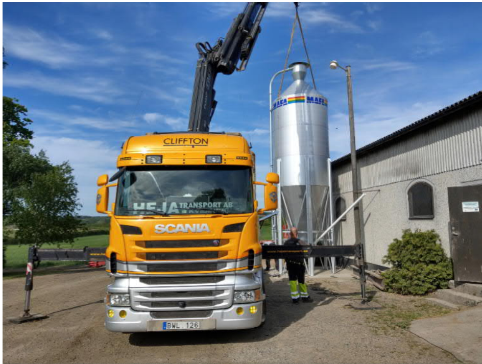
Silo hängande i kranen färdig för fastbultning.
