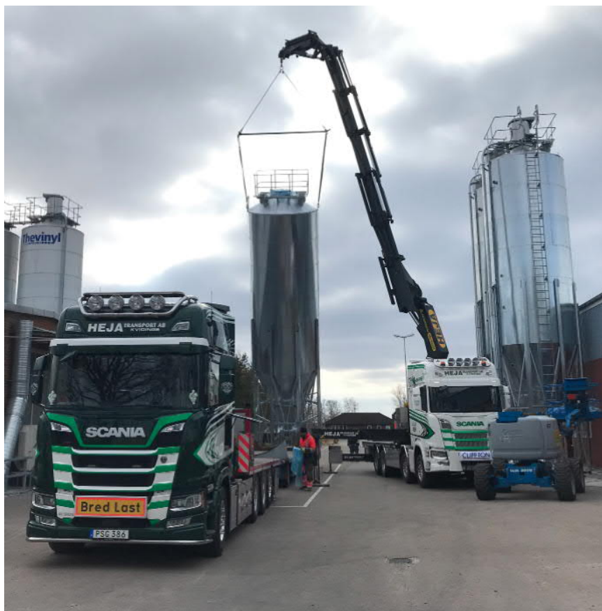
Vid silo med stor diameter eller t ex takplattform med räcke kan lyftok behövas för att inte riskera skada på silon.
